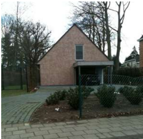
Foto 2: Woning waarbij de voordeur niet meer zichtbaar is
