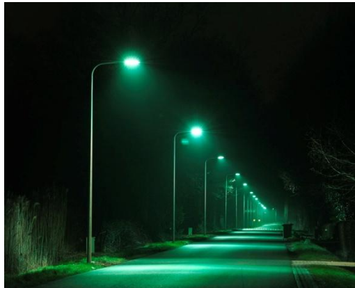
Figuur 7.32: LED-verlichting, foto tctubantia.nl
