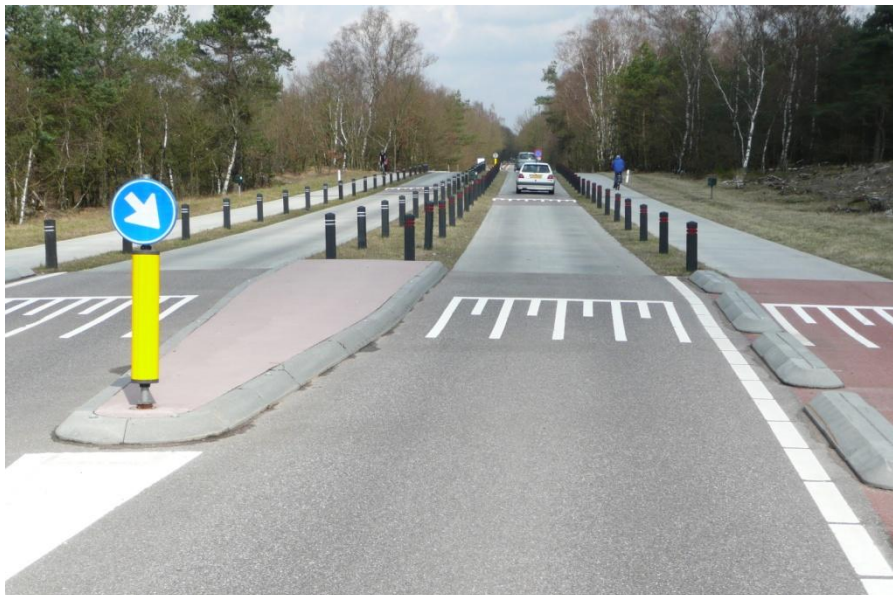
Figuur 7.28: Snelheidsremmende maatregelen en maximumsnelheid van 30 km/h bij wildwissel N804, foto Jan Willem Ooms
