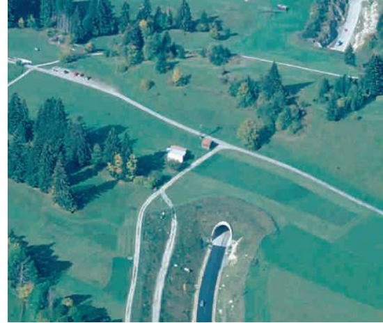
Figuur 7.7: Tunnel in Beieren, Duitsland, foto COST 341
