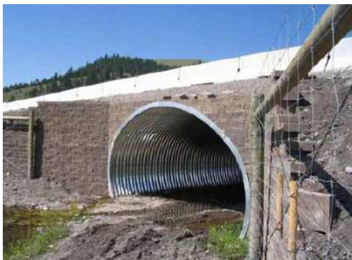
Figuur 7.4: Faunatunnel onder Highway 93, Montana USA, foto Marcel Huijser
