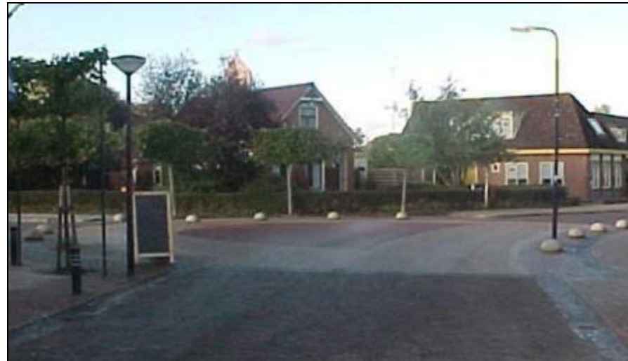
Gelijkwaardige kruispuntoplossing waar gebruik wordt gemaakt van de aanwezige voorzieningen langs het kruispunt, verharding: klinkers
