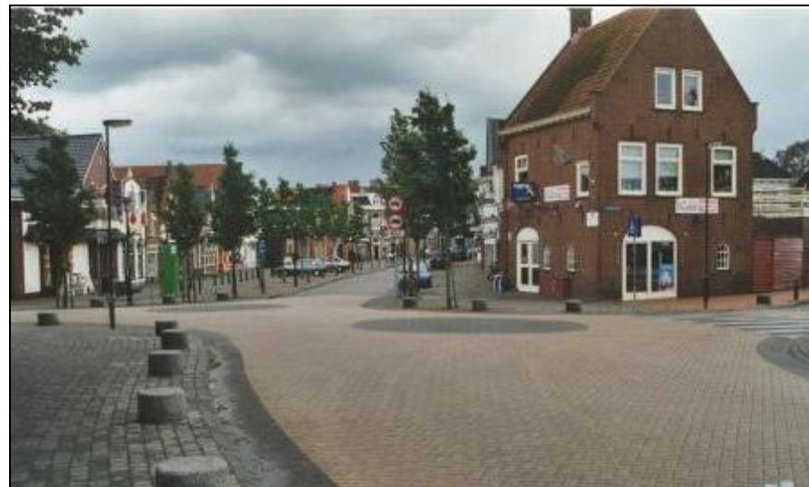
Gelijkwaardige kruispuntoplossing met attentievlakken en fysieke scheiding met trottoir, verharding: klinkers
