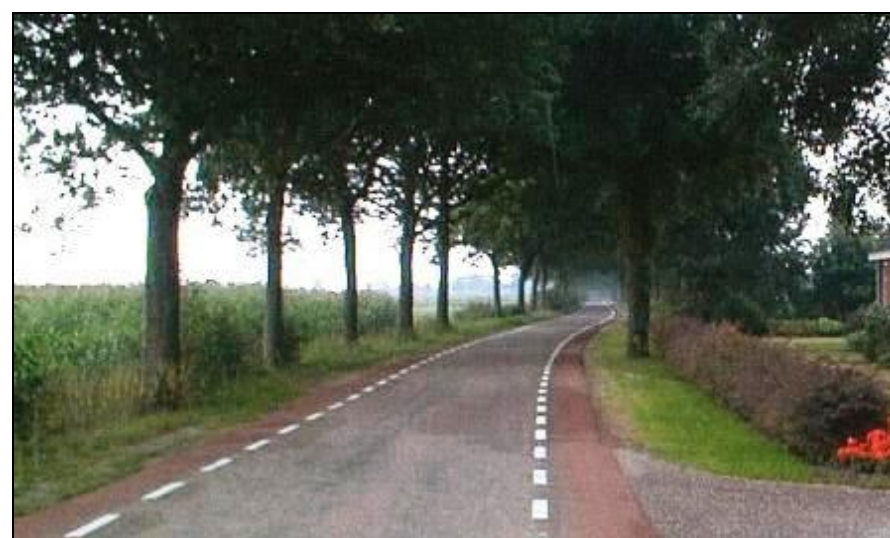
Figuur 76, Wegvak met fietssuggestiestroken dus menging van verkeer, maximumsnelheid 60 km/h, verharding asfalt
