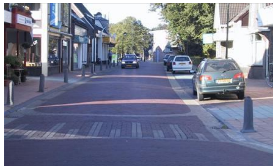
Figuur 88, Erftoegangsweg, parkeren op gelijke hoogte. verharding klinkers
