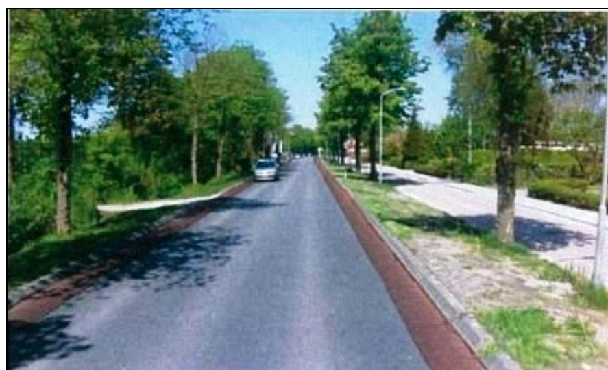
Figuur 28, Erftoegangsweg type 2 met aan weerszijden rabatstroken, verharding asfalt
