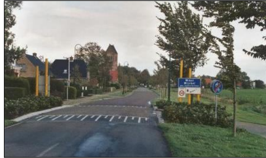
Poortconstructie met snelheidsremmer en verandering van wegbeeld, verharding overgang van asfalt naar klinkers
