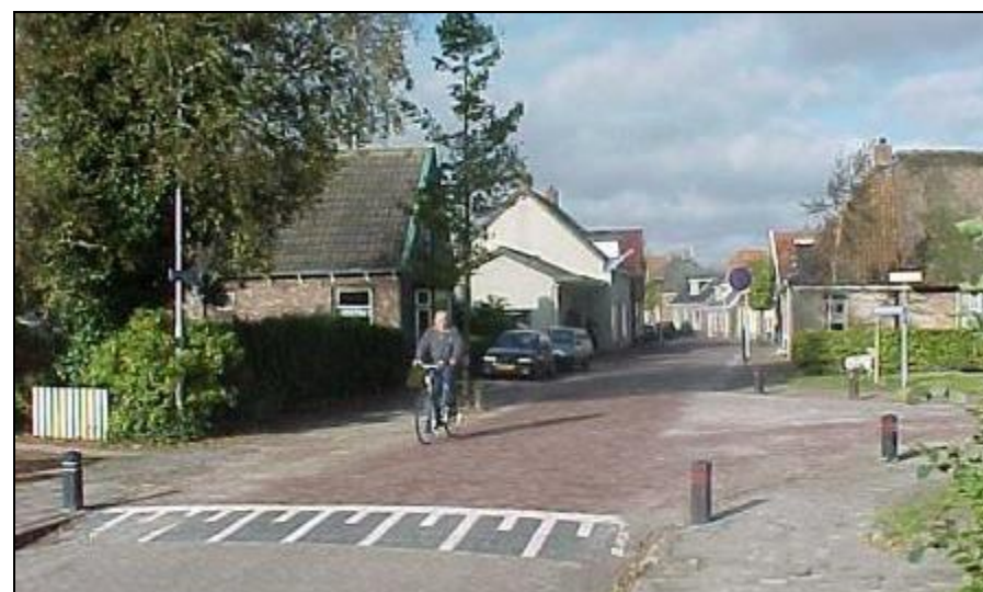
Figuur 66, Gelijkwaardige kruispuntoplossing, verharding klinkers
