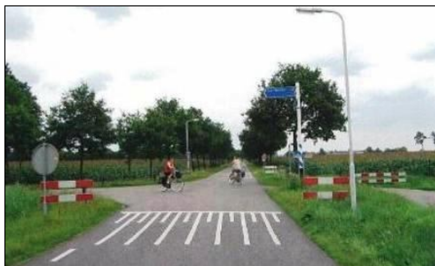
Figuur 30, Verkeerstechnische kruispuntoplossing, verharding asfalt
