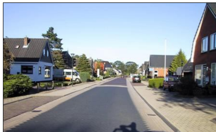
Figuur 87, Erftoegangsweg zonder belijning maar met rabatstroken. Parkeren op zelfde hoogte als rijbaan. Verharding klinkers
