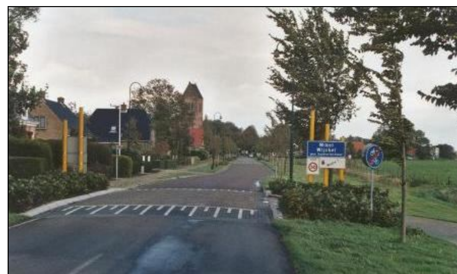
Figuur 34, Poortconstructie met snelheidsremmer en verandering van wegbeeld, verharding overgang van asfalt naar klinkers
