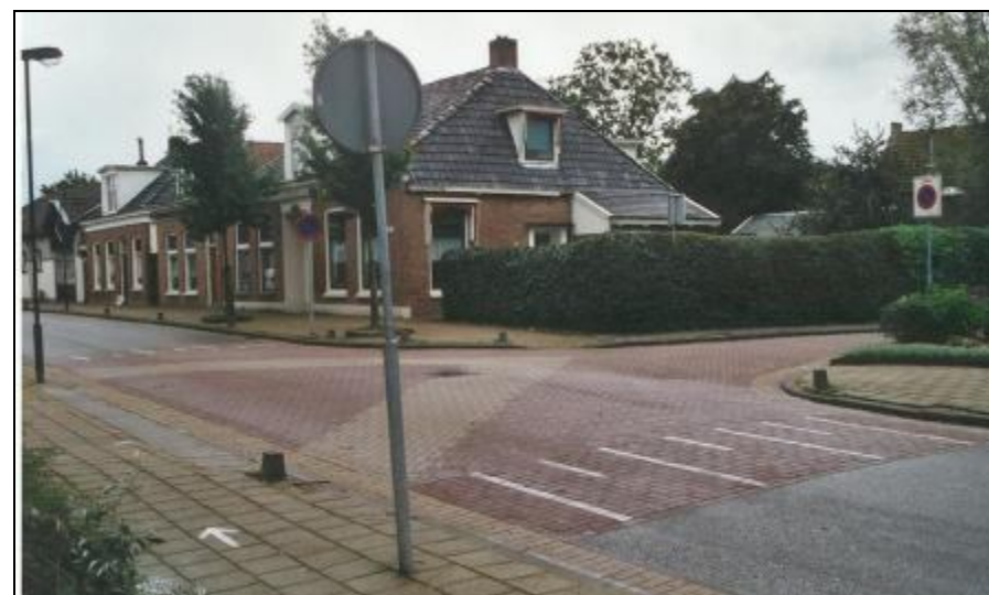
Figuur 67, Gelijkwaardige kruispuntoplossing met attentievak, verharding klinkers
