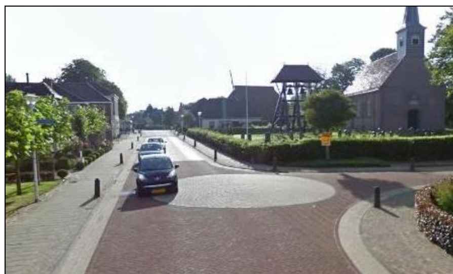
Figuur 43, Gelijkwaardige kruispuntoplossing met attentievlak in midden, verharding klinkers
