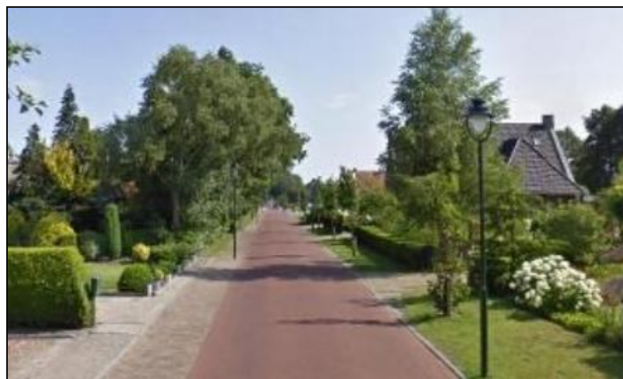
Figuur 40, Wegvak mening van verkeer zonder hoogteverschil, verharding klinkers
