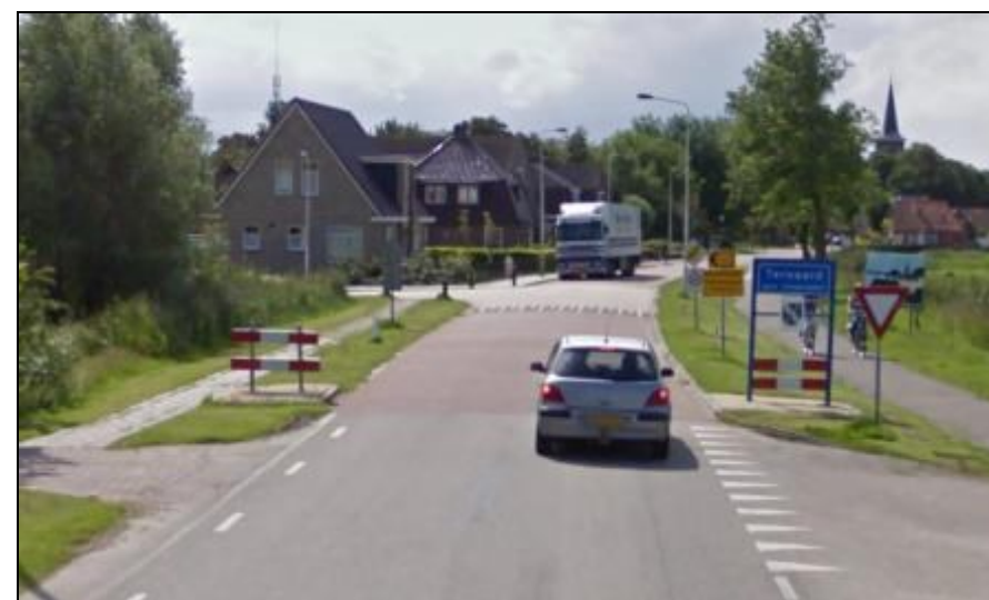
Figuur 74, Poortconstructie waarbij er een overgang is van asfalt naar klinkers, verderop een plateau. Het wegbeeld verandert duidelijk
