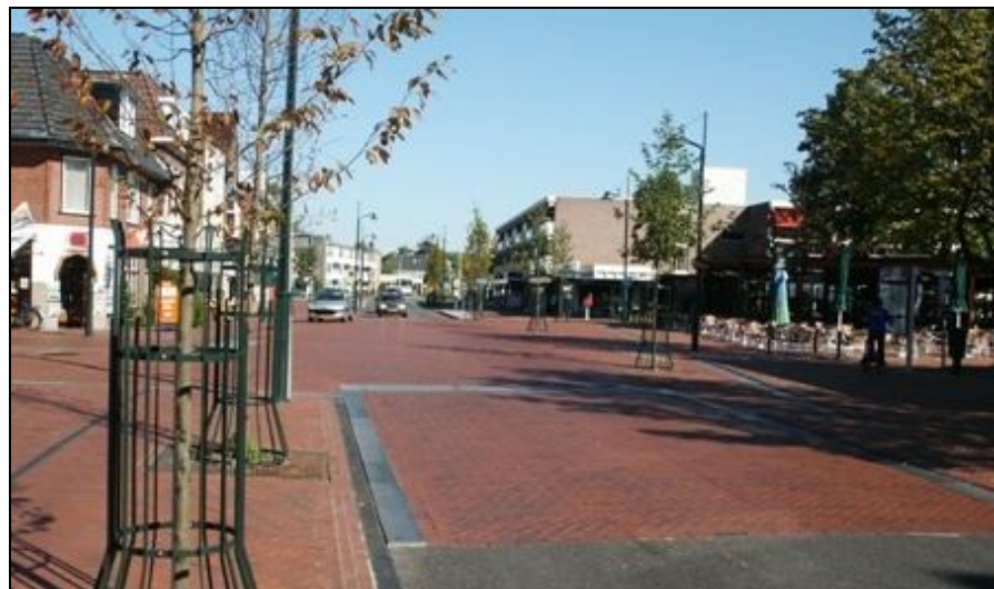
Kruispuntoplossing als een plein, waar functies samenkomen, verharding: overgang asfalt naar klinkers
