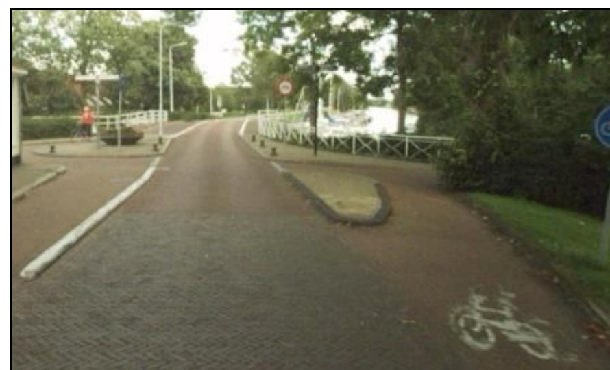
Figuur 85, Wegvak waarbij het gemotoriseerde verkeer voorrang heeft op het fietsverkeer, fietsers moeten eerst naar rechts om vervolgens over te steken en aan de linkerzijde hun weg te vervolgen
