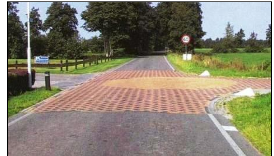
Kruispuntoplossing waarbij rekening is gehouden met inpassing in het omliggende gebied, verharding combinatie: klinkers met asfalt
