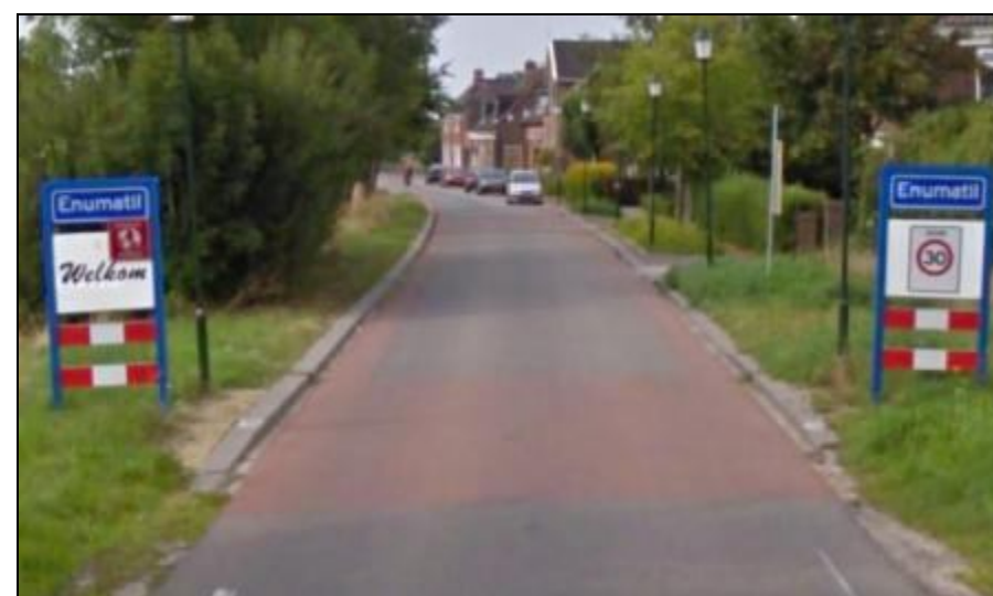
Figuur 35, Komgrens waarbij wegbeeld wijzigt, verharding overgang asfalt naar asfalt in combinatie met rabatstrook
