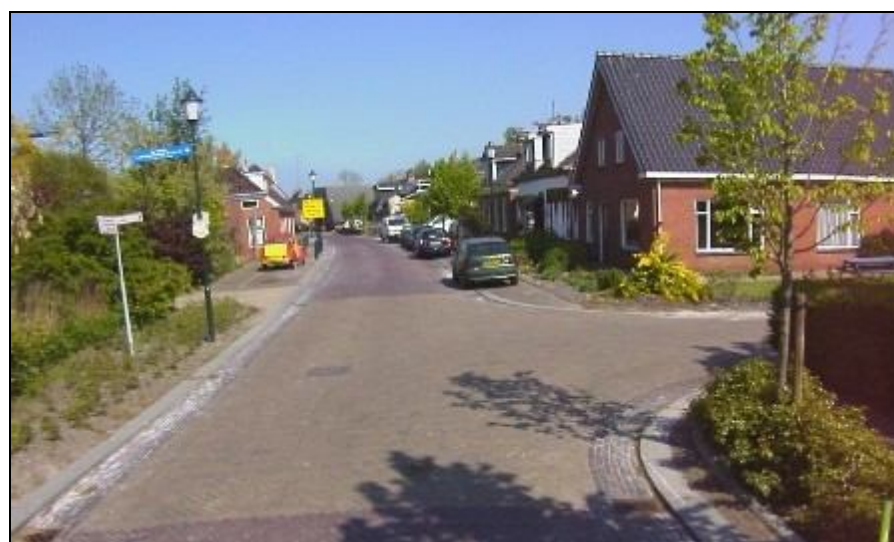
Figuur 42, Gelijkwaardige kruispuntoplossing, verharding klinkers
