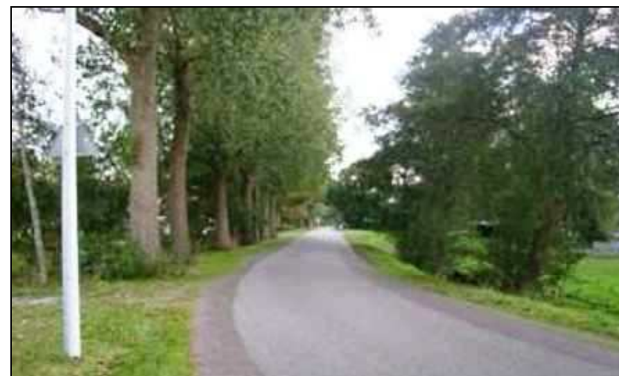
Figuur 59, Wegvak waarbij sprake is van menging van verkeer, aan weerszijden een rabatstrook, verharding asfalt in combinatie met klinkers
