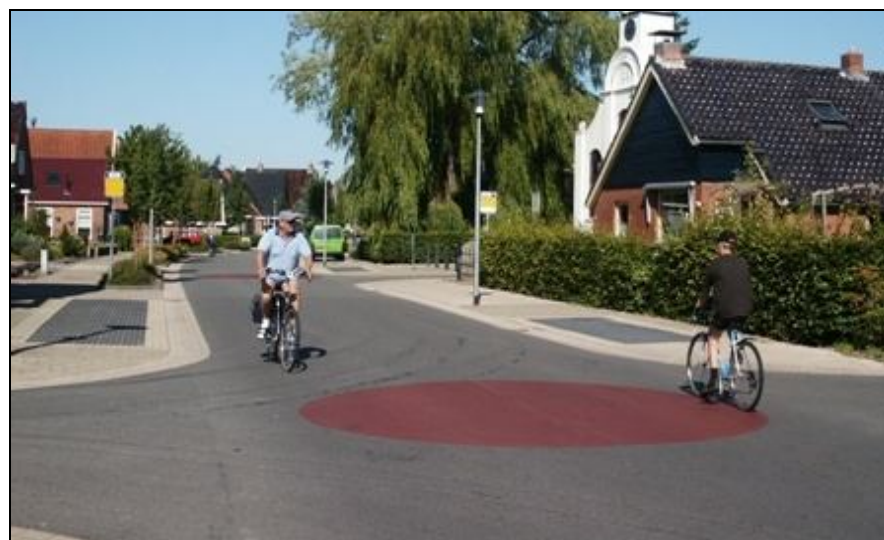
Figuur 51, Gelijkwaardige kruispuntoplossing met attentievak, verharding asfalt
