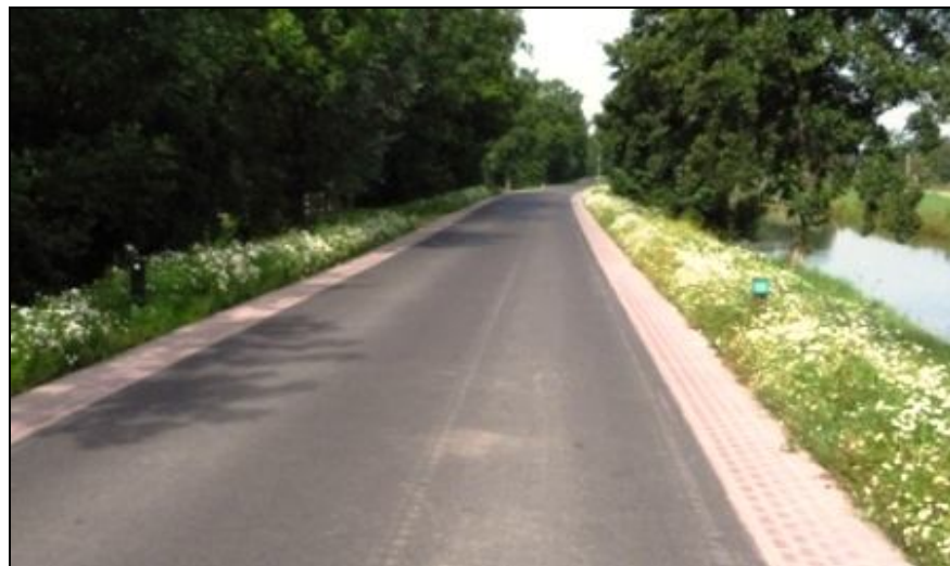
Wegvak waarbij sprake is van menging van verkeer met aan weerszijden een rabatstrook, maximum snelheid 60 km/h, verharding asfalt
