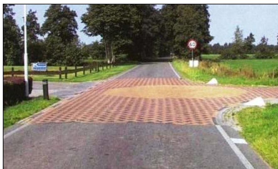
Figuur 31, Kruispuntoplossing waarbij rekening is gehouden met inpassing in het omliggende gebied, verharding combinatie klinkers met asfalt
