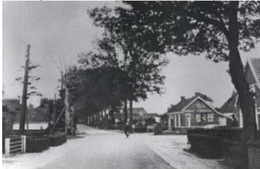
Ter hoogte van Provincialeweg nr. 26 kijkend in oostelijke richting
