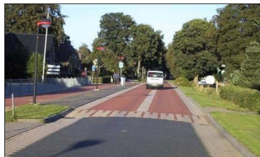
Figuur 58, Wegvak waarbij de fietsers zijn gescheiden van het autoverkeer, verharding klinkers
