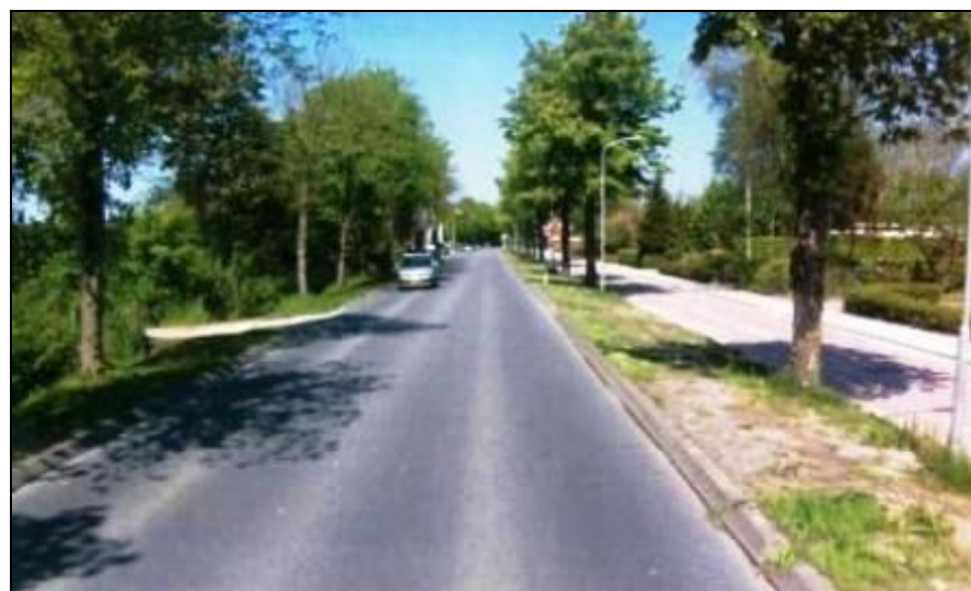
Figuur 27, Erftoegangsweg type 2 zonder as- en kantbelijning, verharding asfalt
