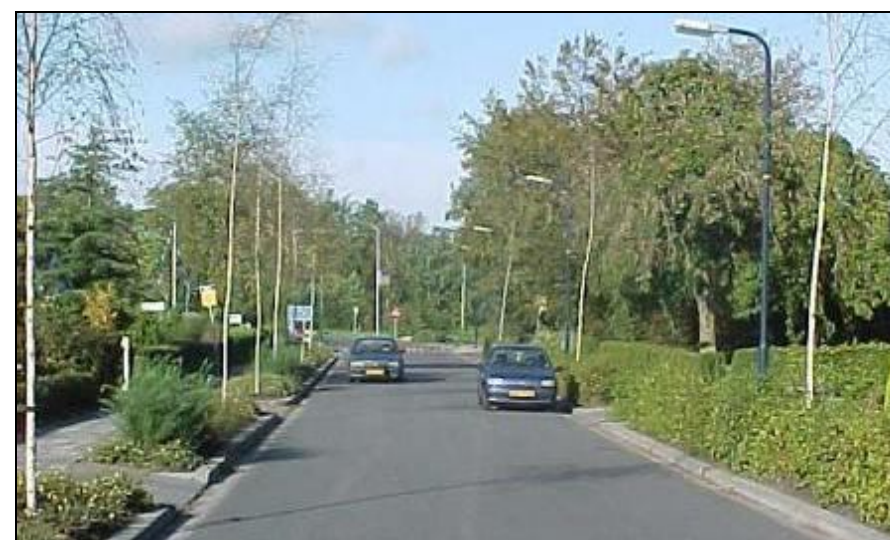
Figuur 65, Wegvak waarbij sprake is van menging van verkeer, verharding asfalt
