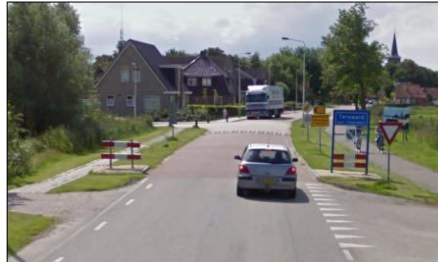
Poortconstructie waarbij er een overgang is van asfalt naar klinkers, verderop een plateau. Het wegbeeld verandert duidelijk
