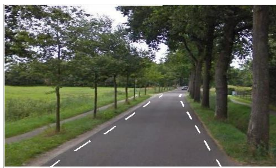
Figuur 53, Erftoegangsweg type 1 met kantbelijning, verharding asfalt
