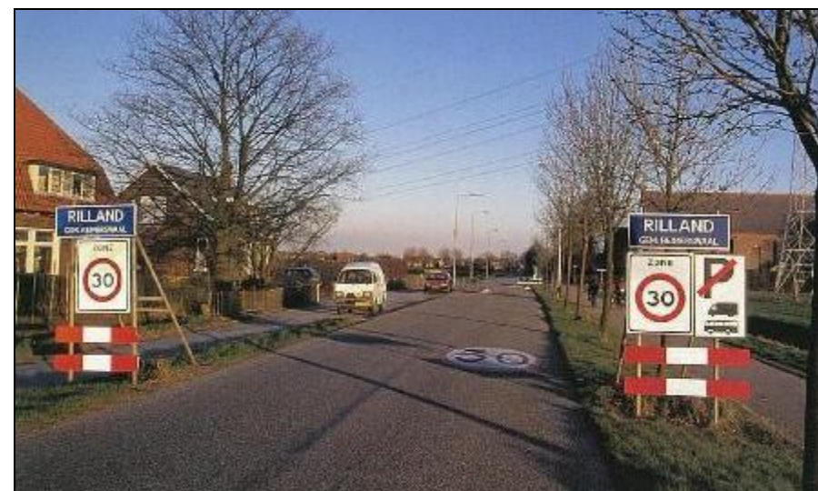
Figuur 33, Poortconstructie zonder verandering van wegbeeld, verharding asfalt
