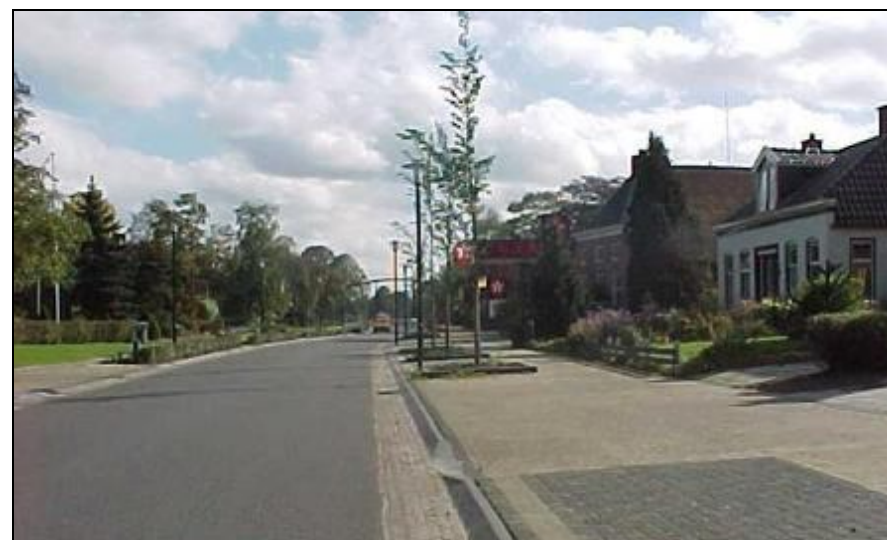
Figuur 86, Erftoegangsweg zonder belijning maar met rabatstrook. Parkeervakken verhoogd uitgevoerd. Verharding combinatie klinkers en asfalt
