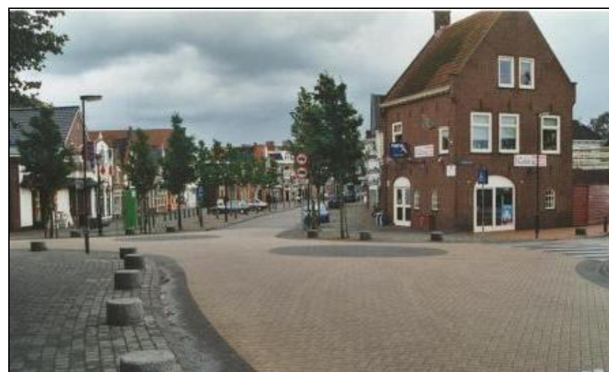
Figuur 45, Gelijkwaardige kruispuntoplossing met attentievlakken en fysieke scheiding met trottoir, verharding klinkers
