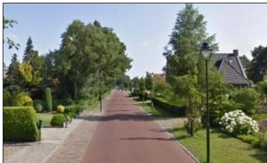
Figuur 52, Wegvak mening van verkeer zonder hoogteverschil, verharding klinkers
