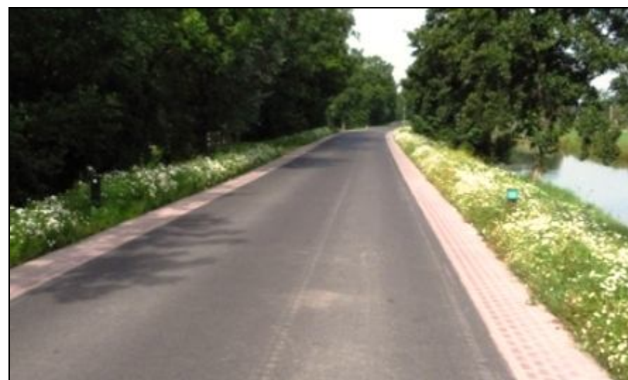
Figuur 77, Wegvak waarbij sprake is van menging van verkeer met aan weerszijden een rabatstrook, maximum snelheid 60 km/h, verharding asfalt
