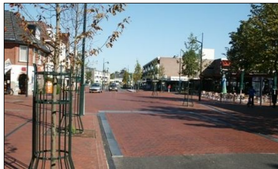
Figuur 47, Kruispuntoplossing als een plein, waar functies samenkomen, verharding overgang asfalt naar klinkers
