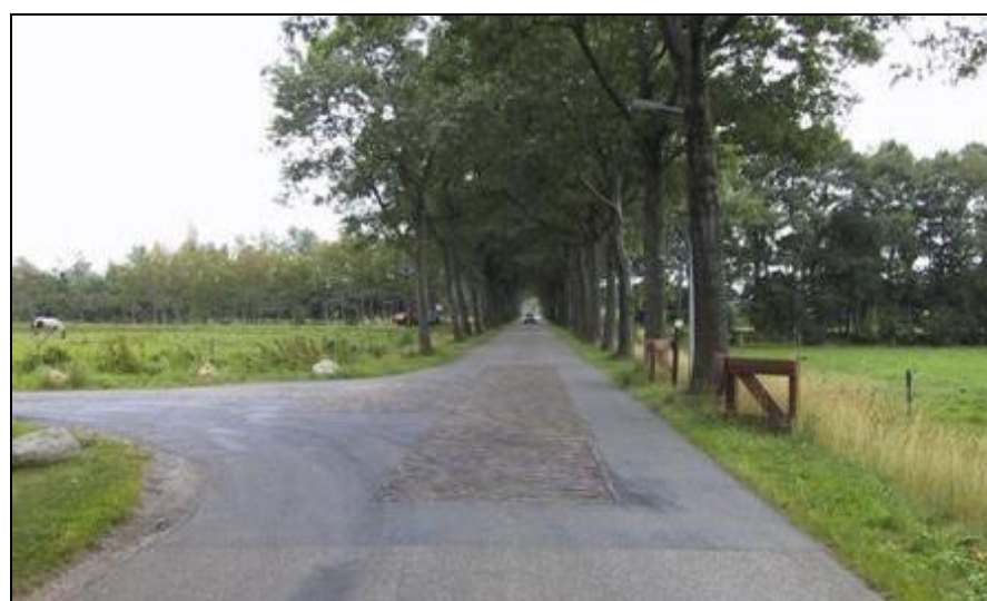
Figuur 55, Gelijkwaardige kruispuntoplossing met attentievlak, combinatie tussen klinkers en asfalt
