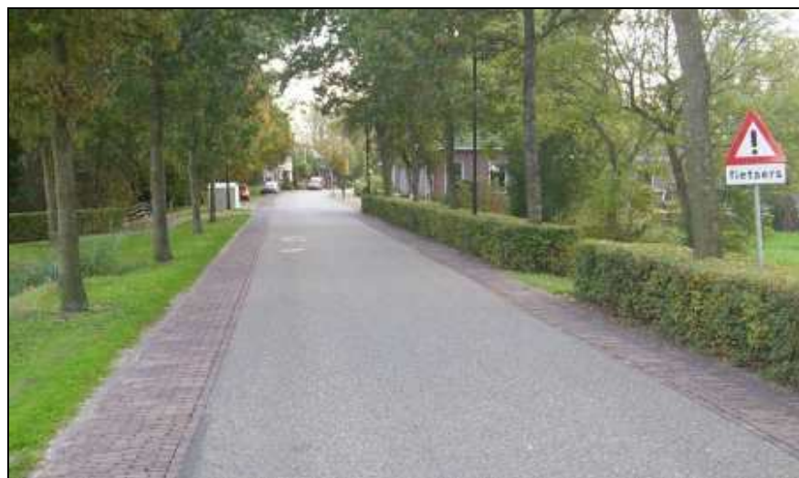
Wegvak waarbij sprake is van mening van verkeer, aan weerszijden een rabatstrook, verharding asfalt in combinatie met klinkers
