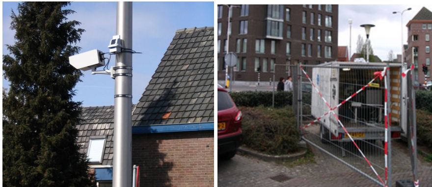
Figuur 7: links) Een EnviroWatch sensor, bevestigd aan een straatlantaarn naast een camera rechts) de aanhanger met de instrumenten
