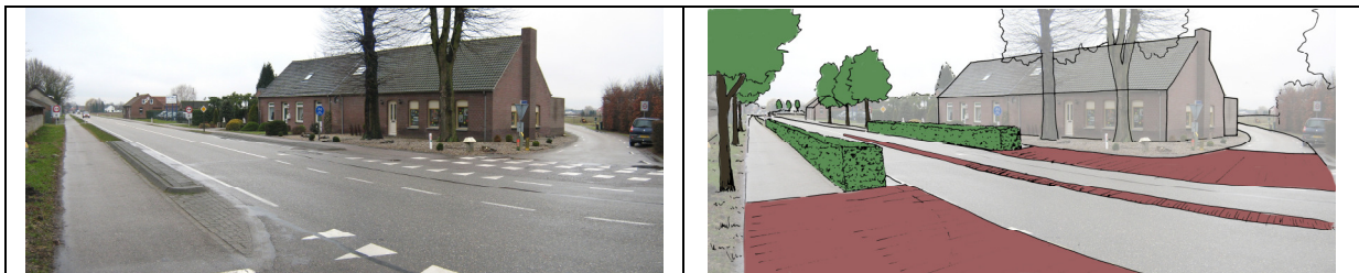
Figuur 3: Fysieke en visuele versmalling in een gebiedsontsluitingsweg buiten de bebouwde kom
