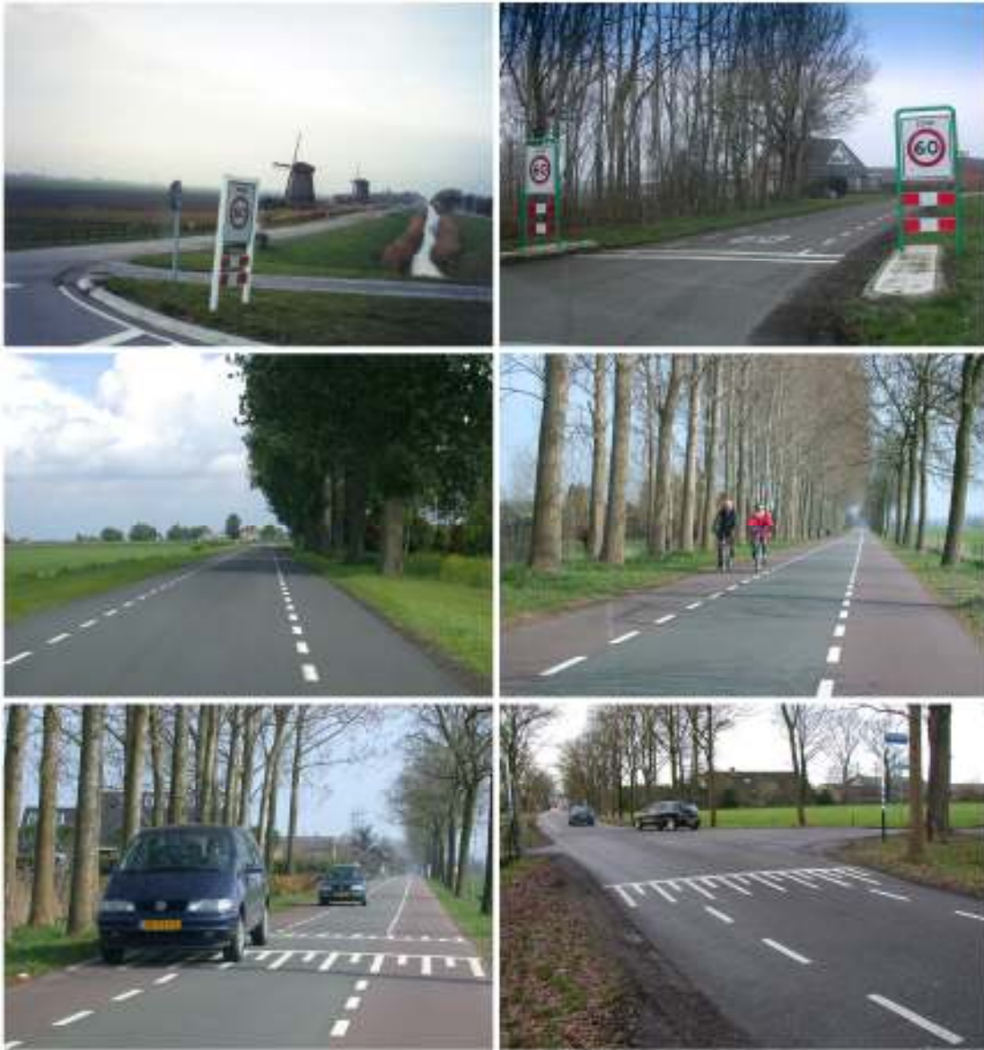
Figuur 1. Voorbeelden van sobere inrichtingsmaatregelen. Zoneborden met dubbele streep over de weg (boven); kantmarkering in plaats van middenmarkering (midden, links); rode kantstroken als fietssuggestiestrook (midden, rechts); drempel in wegvak (onder, links) en plateau op kruising (onder, rechts).
