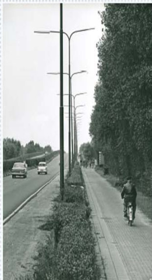
Lichtmasten langs rijksweg 13 in de jaren zestig.
