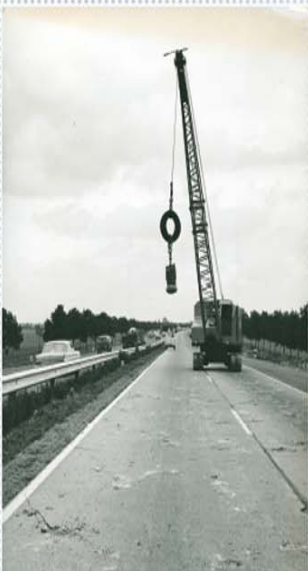
Sloop van een betonnen rijstrook, rijksweg 12, jaren zestig. De vervanging van beton door asfalt op de Nederlandse autosnelwegen duurde meer dan 10 jaar.
