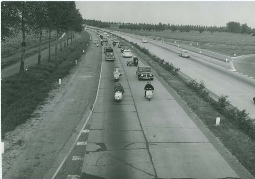
Rijksweg 12 bij Houten in 1959. De rijstroken rechts zijn al geasfalteerd, links liggen nog betonnen rijstroken.
