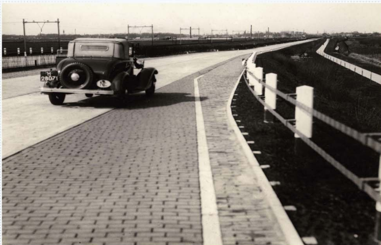
De nieuwe autosnelweg kende betonnen rijbanen, klinkers op op- en afritten, een middenberm en als eerste verbinding ter wereld doorlopende vluchtstroken. (Spaarnestad Photoarchief)
