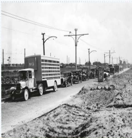
Verbetering van rijksweg 5, Amsterdam-Haarlem. Ook in de jaren dertig leidden wegwerkzaamheden tot files.
