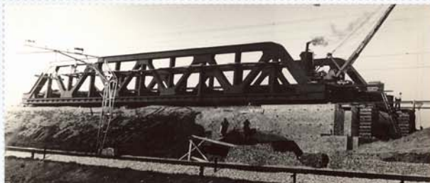
Werkzaamheden bij de brug van de Hofpleinlijn over rijksweg 12. (Spaarnestad Photoarchief)
