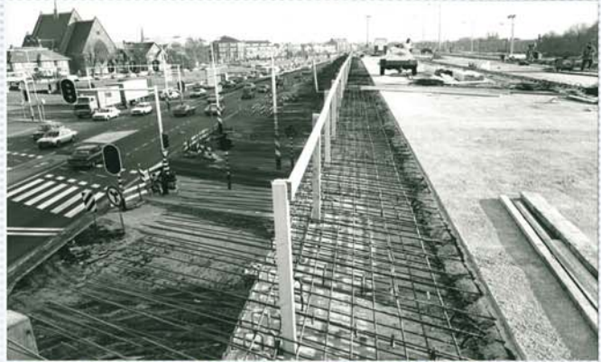
Aanleg van een nieuwe viaduct bij Voorburg, midden jaren zeventig. De bouw van dit viaduct maakte ongelijkvloerse doortrekking van de A12 naar Den Haag mogelijk. (Gemeentearchief Leidschendam-Voorburg)
