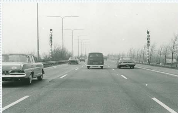
Waarschuwingssysteem voor files (rijksweg 13, rond 1970).
