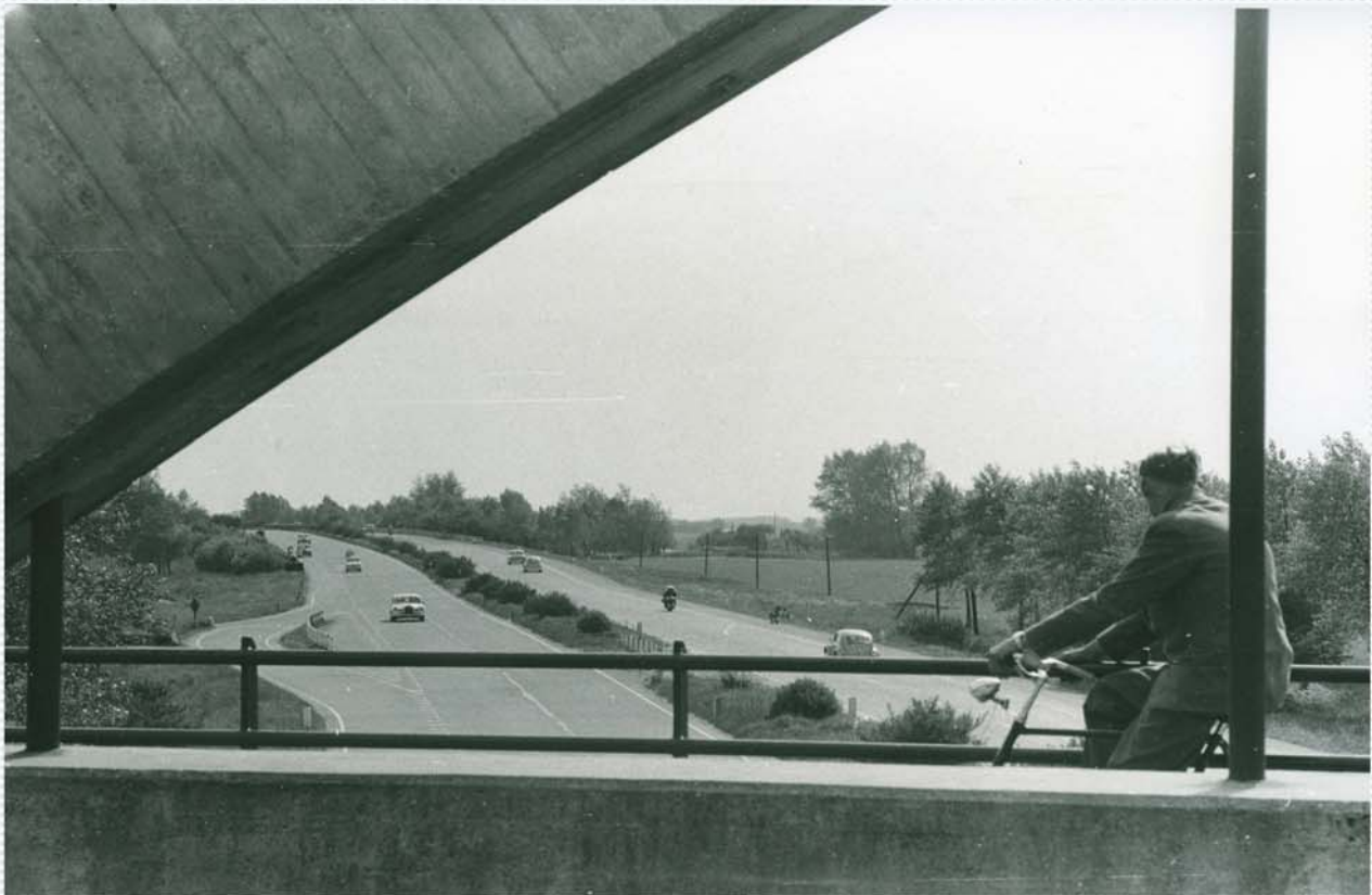
Viaducten boden een goed overzicht op de nieuwe infrastructuur.
