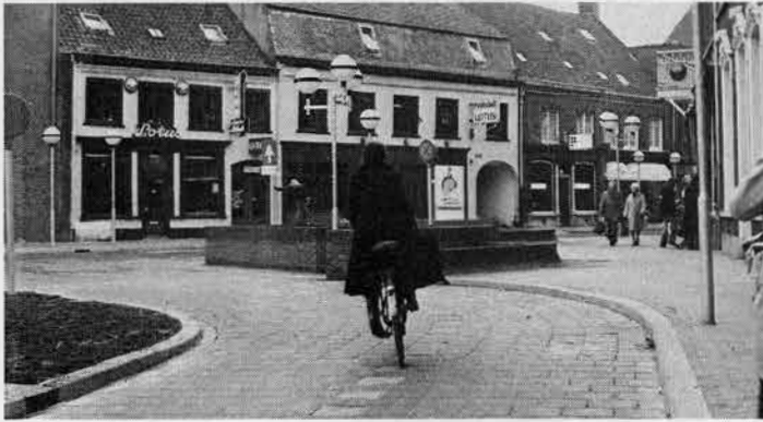
18 (geheel boven). Kruispunt Boomstraat/Wilgenstraat/St. Ceciliastraat: bobbel en een schuine drempel met basaltkeien. 19 (boven). Kruispunt Tivolistraat/Heuvel: muurtjes in de fietsroute.
