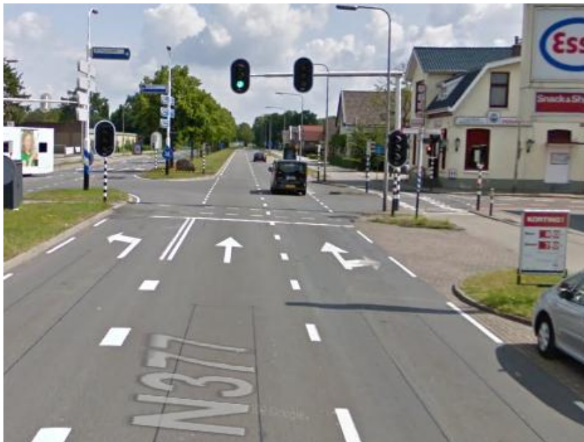
Figuur 23. Verkeersregelininstallatie nabij Slagharen, onderdeel van route U54 (bron: Google Streetview).
