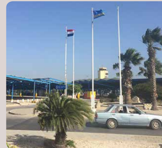
De luchthaven van Aruba met een overkapping van zonnepanelen over het hele parkeerterrein
