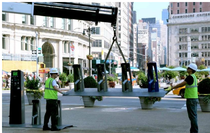
Afbeelding 1. Een modulair station van Citi Bike in New York. Deze modulaire stations zijn makkelijk te plaatsen op iedere locatie (ITDP, 2013)
