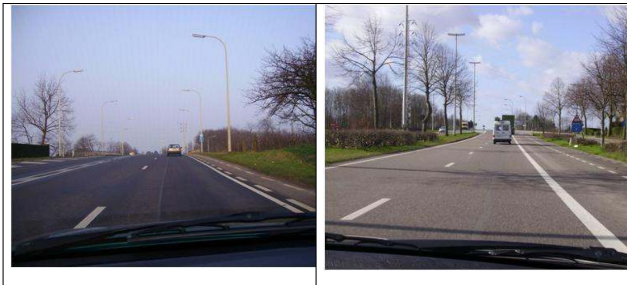
Figuur 6A en 6B: De bomen staan te ver van de rijbaan en te ver van elkaar en hebben daardoor geen effect op snelheidsverlaging.
