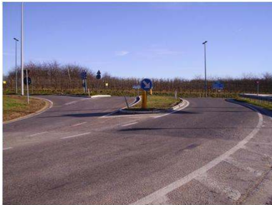
Figuur 5: Rotonde in Sint-Truiden waar de afwezigheid van kunstwerken het detecteren van de rotonde bemoeilijkt.
