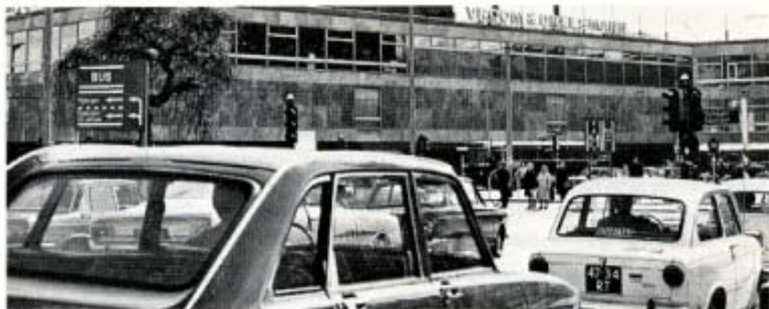
8. Velperplein met aanduidingsborden i.v.m. aanwezigheid busstrook.
