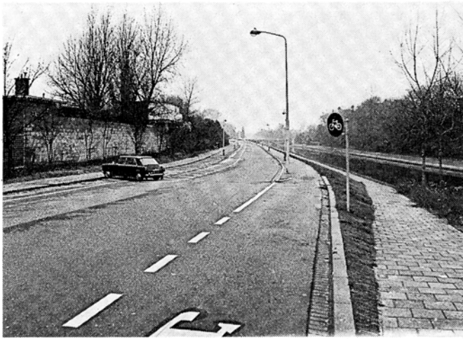
Links: Door het aanbrengen van een parkeerstrook op het fietspad en het instellen van eenrichtingsverkeer is het fietsklimaat hier verslechterd. Een goede, aantrekkelijke doorgaande fietsroute naar Scheveningen werd onbruikbaar.
