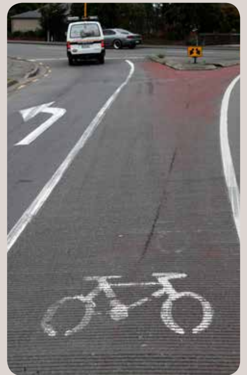
De weg splitst zich met in het midden een verkeerseland. Wil je linksaf als fietser dan rijd je aan de rechterkant van de rijstrook en wil je rechtaf dan eindig je aan de andere kant
