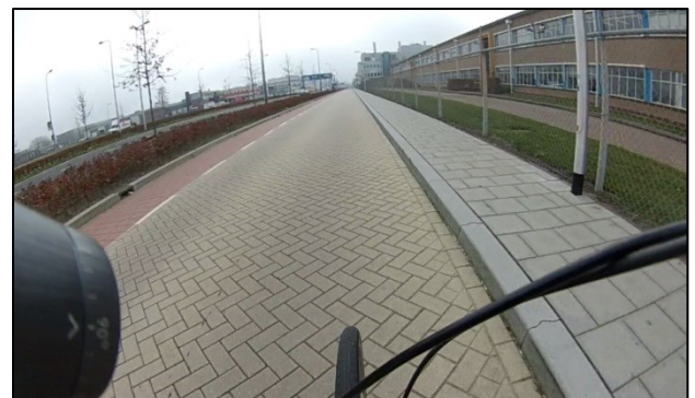
Figuur 62 Parallelweg Ceintuurbaan
