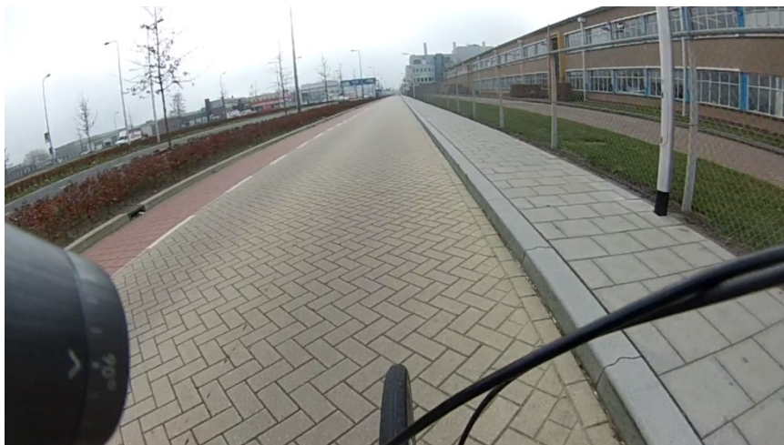
Figuur 66 Parallelweg Ceintuurbaan
