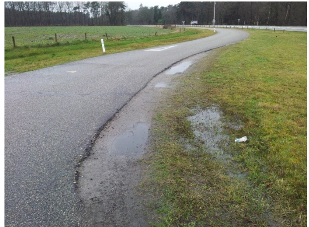
Figuur 3 Voorbeeld berm niet op gelijke hoogte met fietspad (eigen foto)
