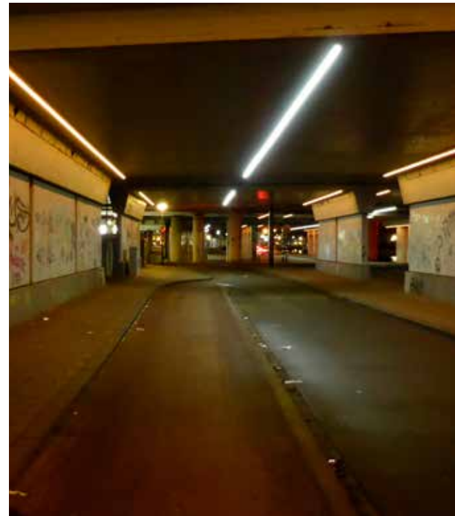
Route 3: onderdoorgang Overschieseweg
