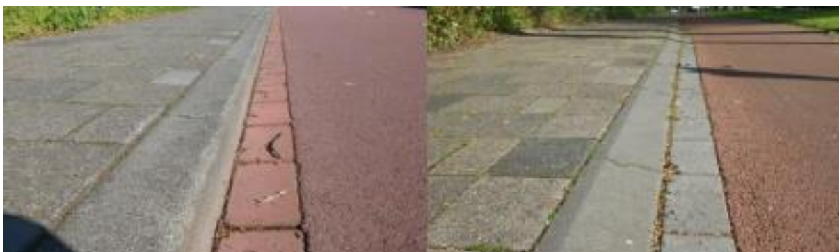
Figuur 3. Standaard trottoirband (links) en vergevingsgezinde fietstrottoirband type C1 (rechts) (Rijkswaterstaat, 2017).
