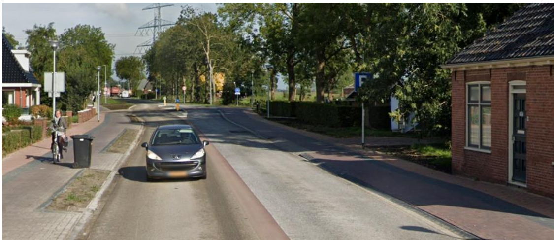
Figuur 14: Attentieverhogende elementen: Veranderende kleur/motief rijbaan, Provincialeweg Sauwerd (bron: GoogleMaps)
