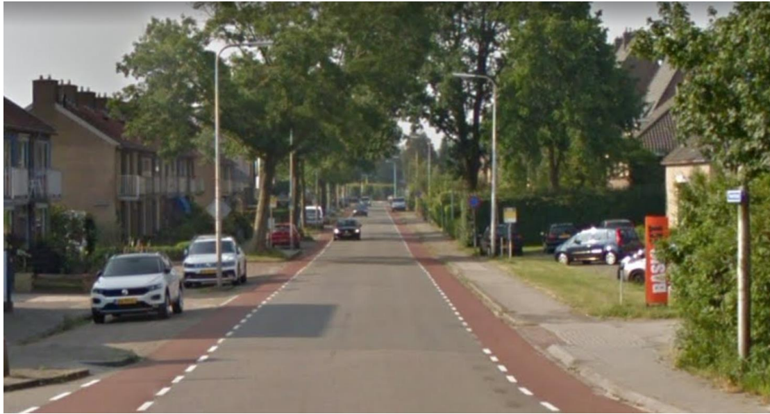
Figuur 5: Pesserstraat Hoogeveen (bron: Google Earth)
